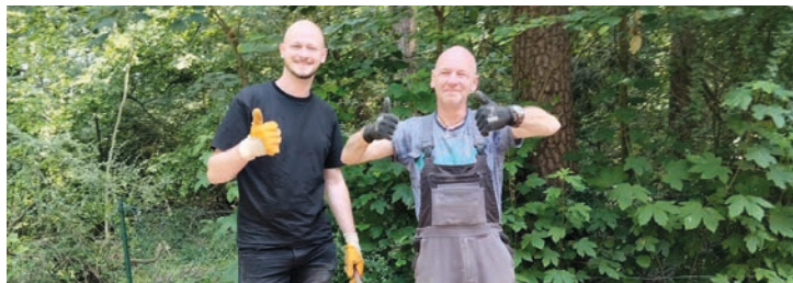
Zupacken für die Zukunft: Simon Friesen (links) und Dirk Steinmeier präsentieren stolz das Ergebnis nach den Pflasterarbeiten für das Gewächshaus-Projekt der Maßnahme MUT.
